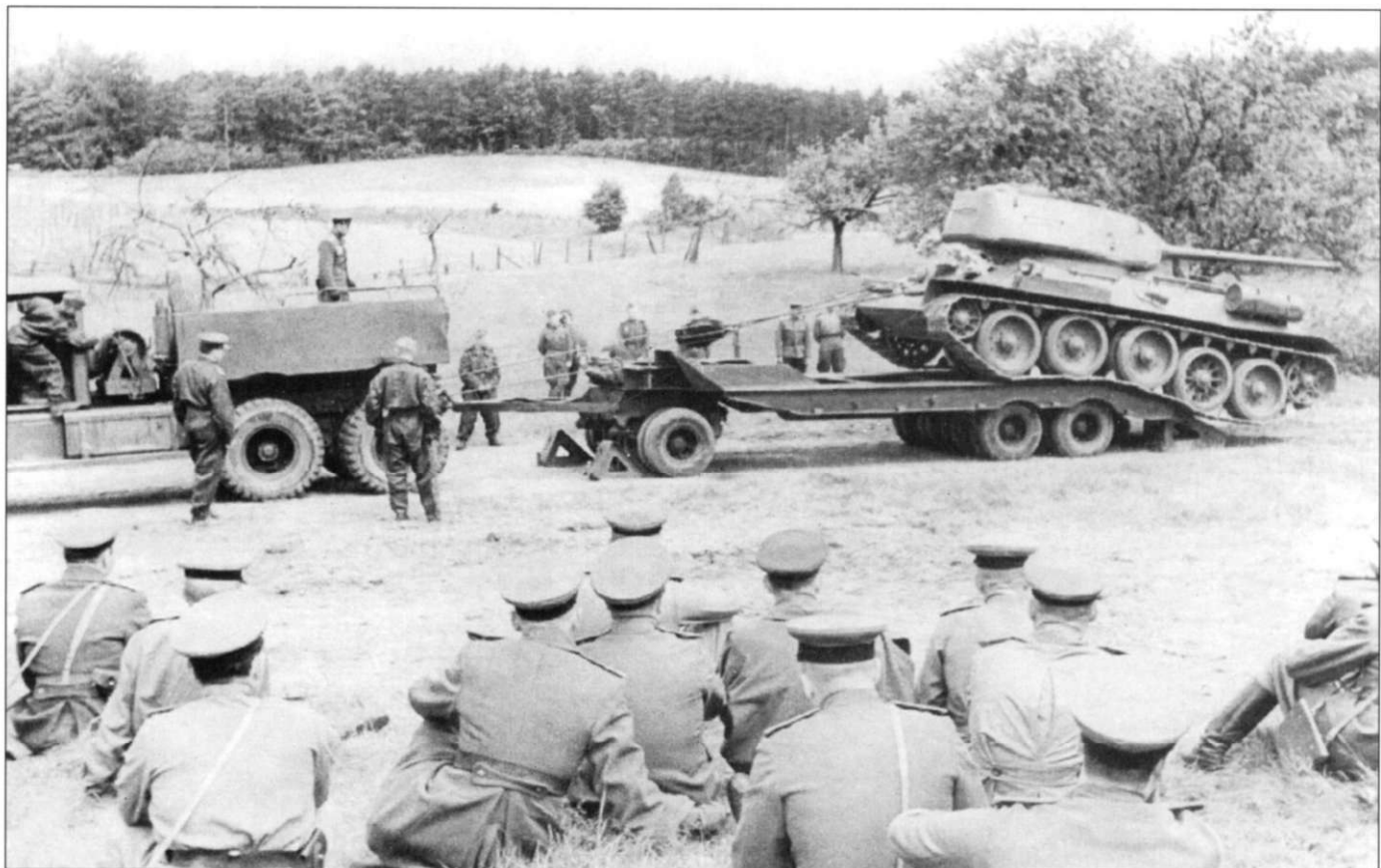
Показательная погрузка танка Т-34-85 на прицеп «Роджерс» М9 с помощью лебедки, установленной на тягаче ТМ 20 «Даймонд 980», Германия, июль 1946 года.
