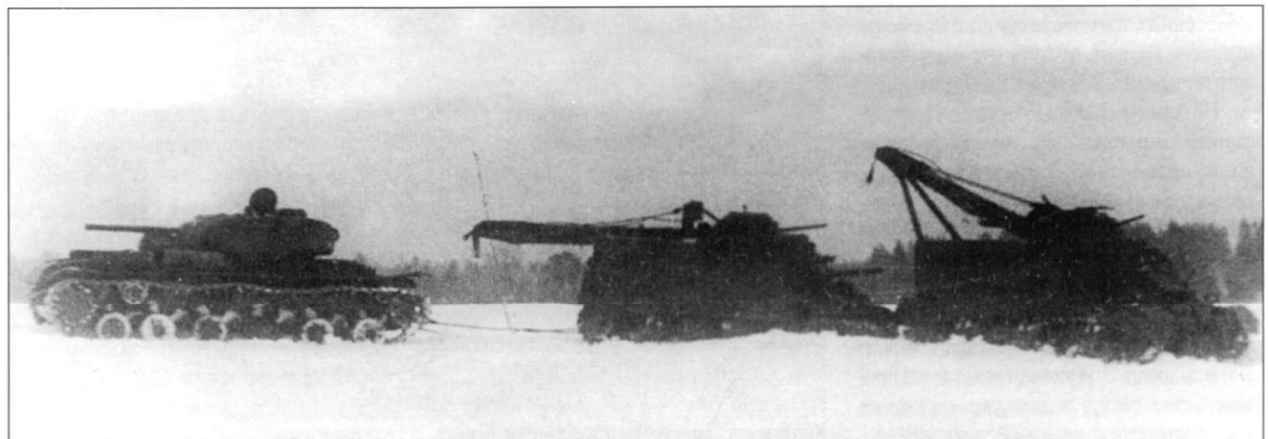
Тяжелый танк КВ-1 буксируют два БРЭМ М31 (Т2), полигон НИИБТ, зима 1942/43 гг.
