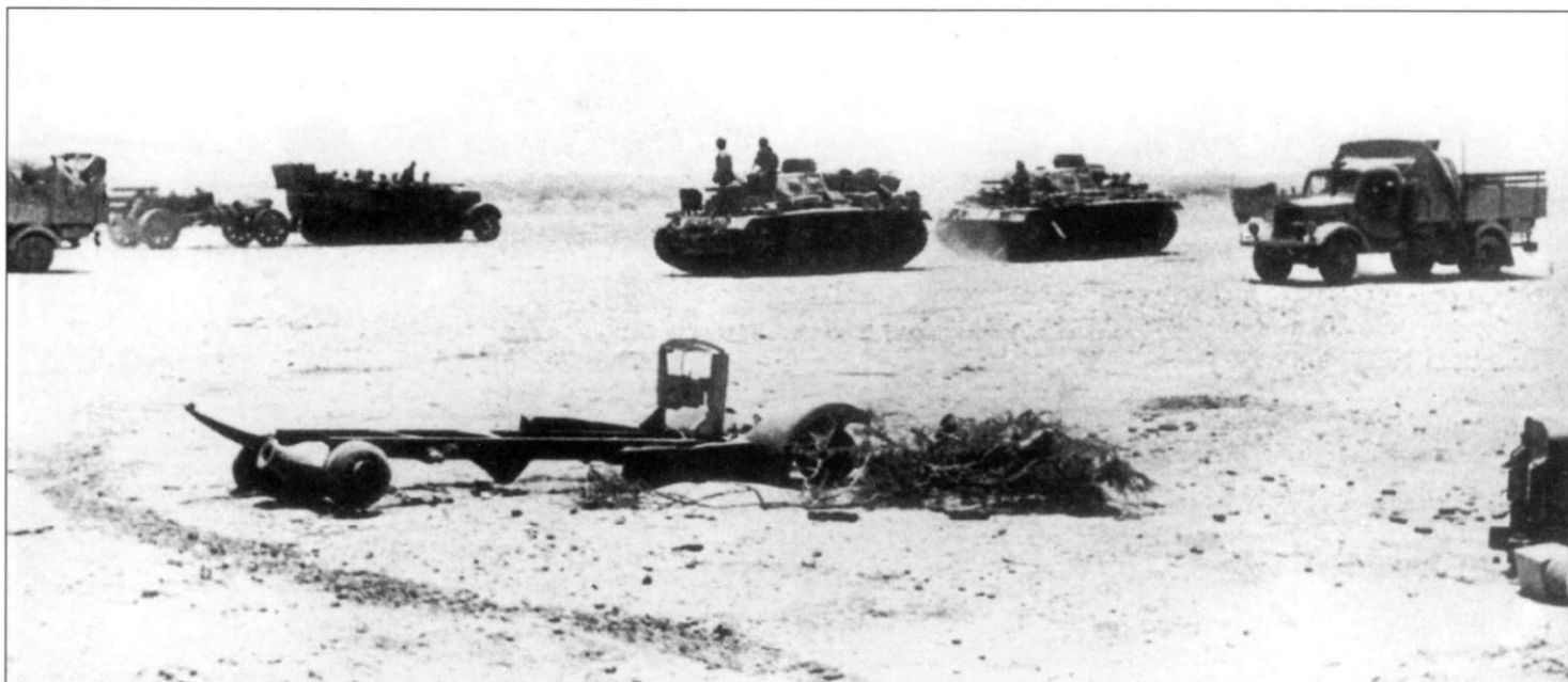
Два танка Pz.Kpfw. III встретили в пустыне на встречном курсе тягач Sd.Kfz. 7 с гаубицей 15 cm sFH-18 на буксире. На переднем плане - остатки какой-то уничтоженной единицы техники.
