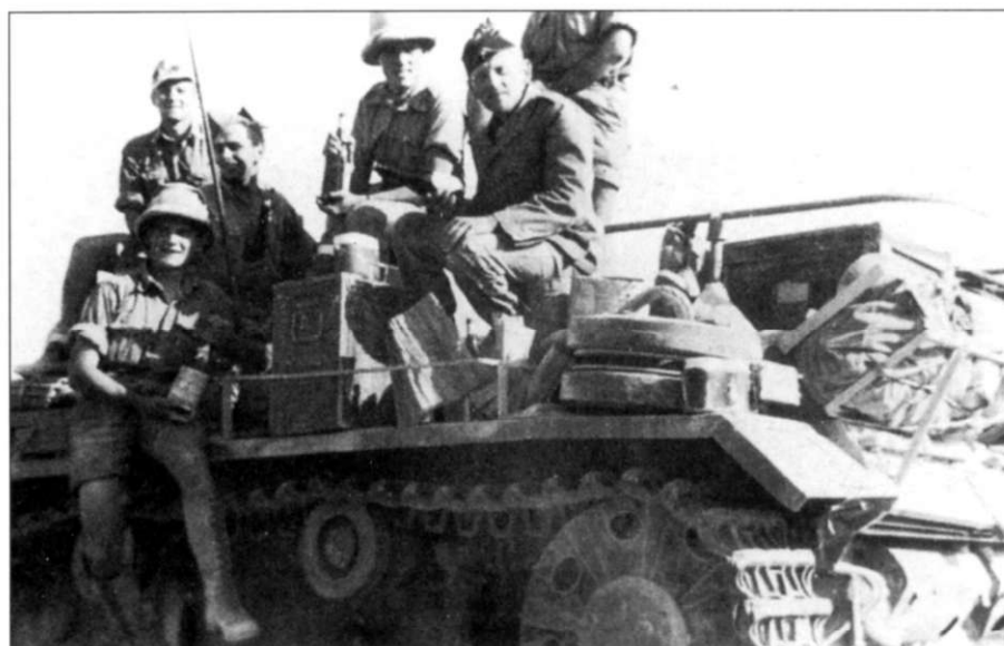
Экипаж командирского танка Pz.Bef.Wg. III Ausf. H позирует военному корреспонденту с трофейным вином в руках. Видна большая рамная антенна над крышей моторного отделения, которой командирские танки отличались от линейных. В конце войны характерные рамные антенны командирских танков заменили на менее бросающиеся в глаза антенны с «метелкой» на конце. Два члена экипажа одели пробковые тропические шлемы. Популярность такие шлемы не пользовались, но использовались до последних дней компании.
