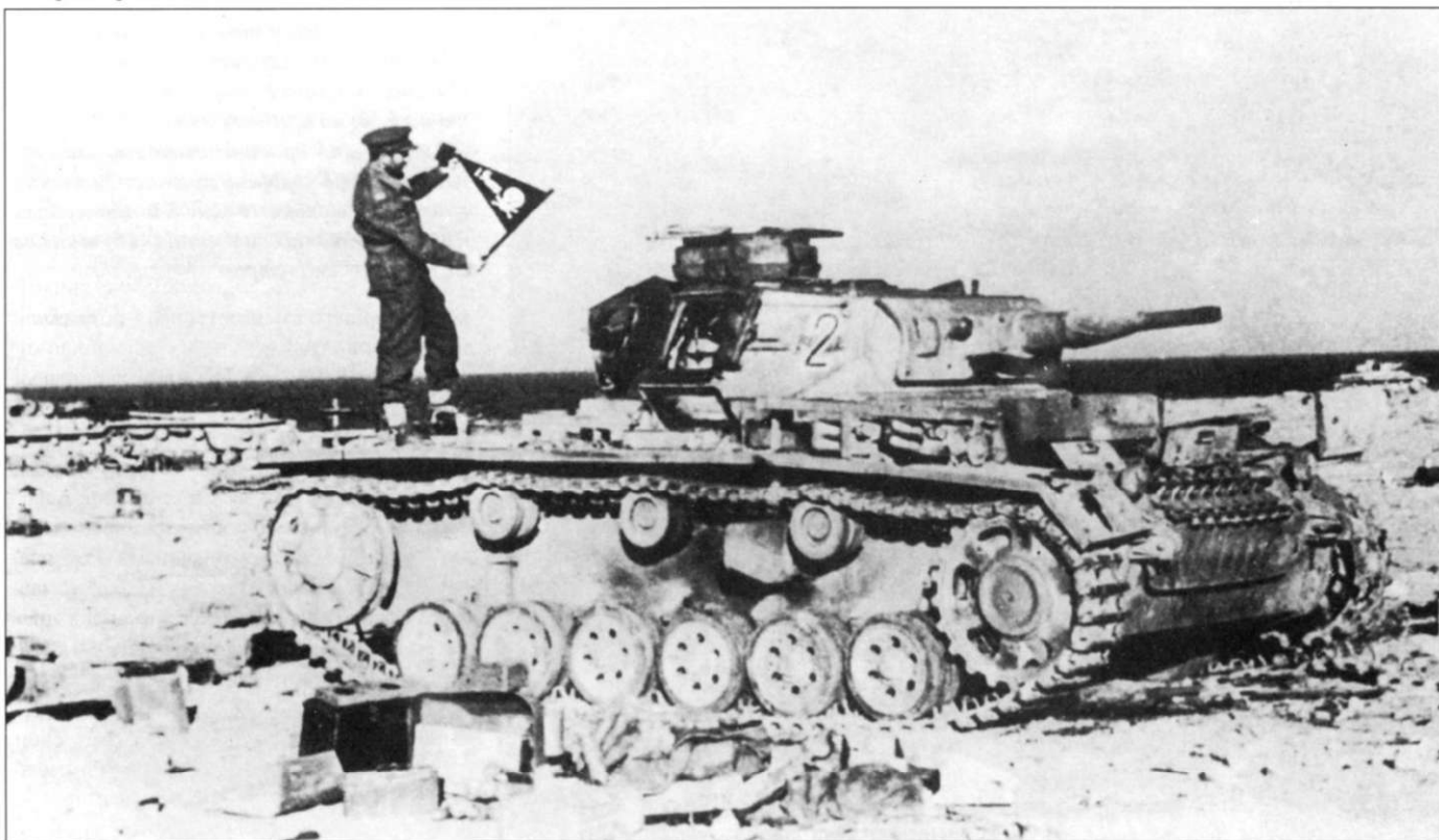
Танк Pz.Kpfw. III Ausf. G из 2-й роты 8-го танкового полка - трофей британских войск, снимок сделан 20 декабря 1941 г. Машина оснащена новыми гусеницами с траками шириной 40 см. Ведущие колеса переделаны, установлены более широкие опорные катки. Британский офицер держит в руках флажок 1-й роты, на флажке - череп с костями и надпись «1 котр.». На заднем плане просматриваются остатки трех танков Pz.Kpfw. IV.
