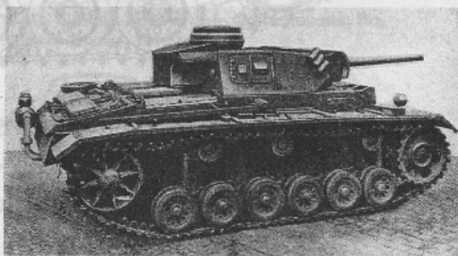
PzKpfw III Ausf. M с модифицированной выхлопной системой
